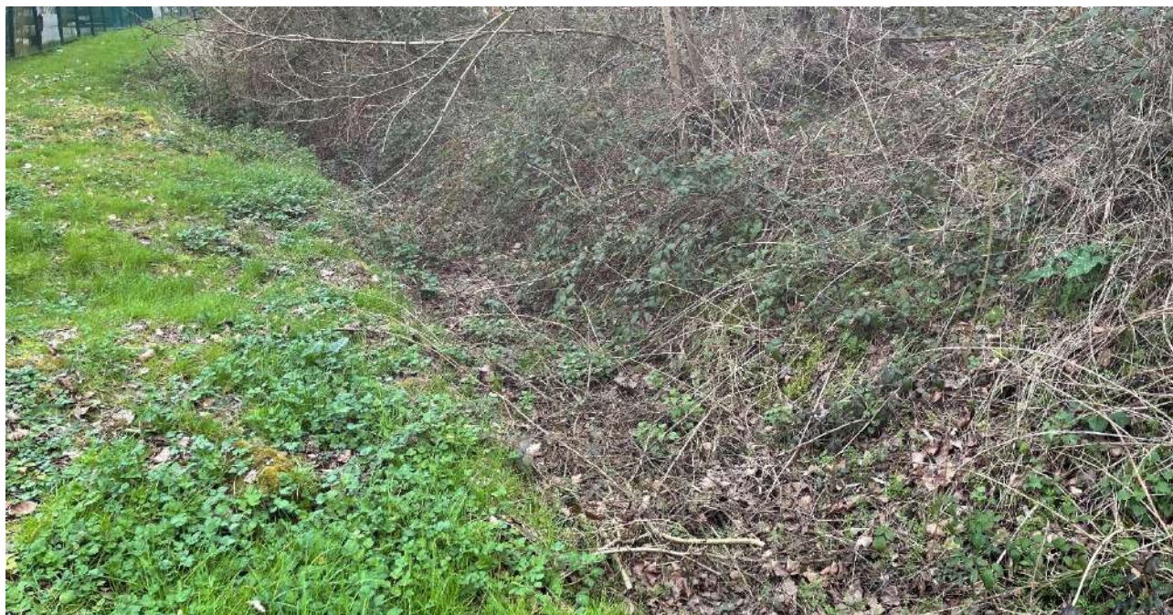
Figure 12 : Fossé présent au pied du talus de l'ancienne voie ferrée
