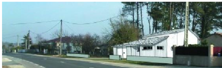
Extension habitation – Projet
